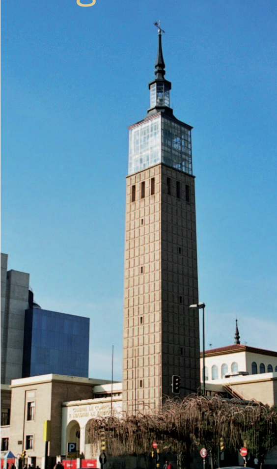
Sede de la Cámara de Comercio e Industria de Zaragoza
